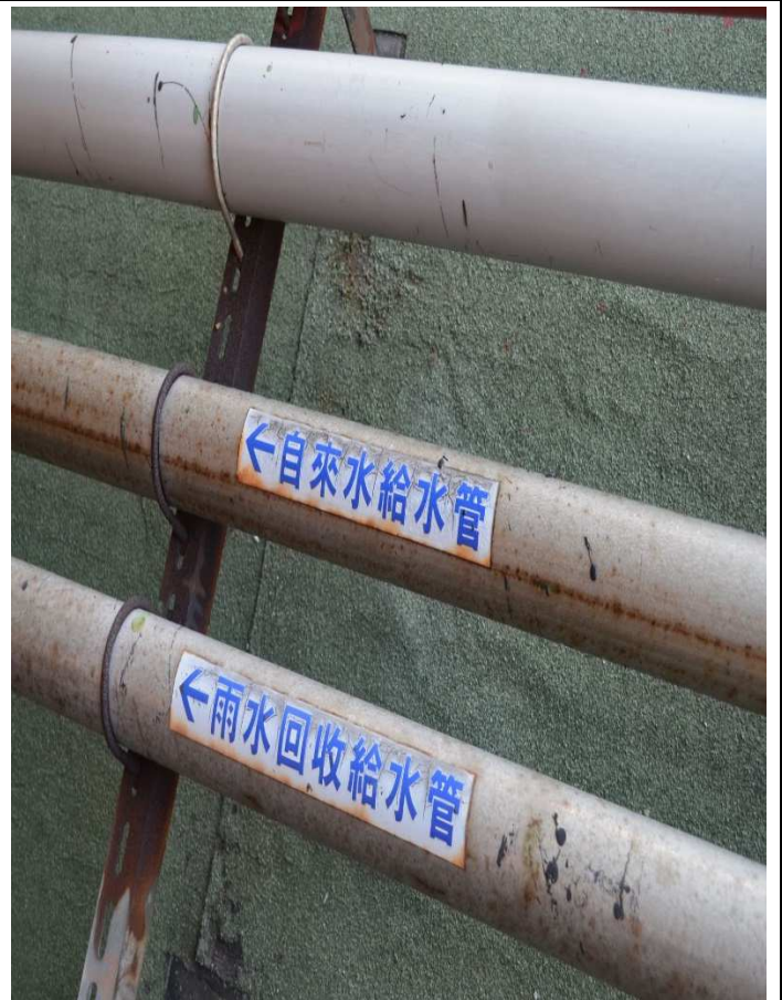
學校設有雨水回收系統裝置，再利用到廁所馬桶沖洗用水，以達到資源再利用。
