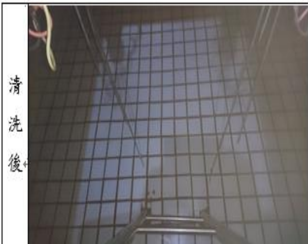
定期清洗水塔
