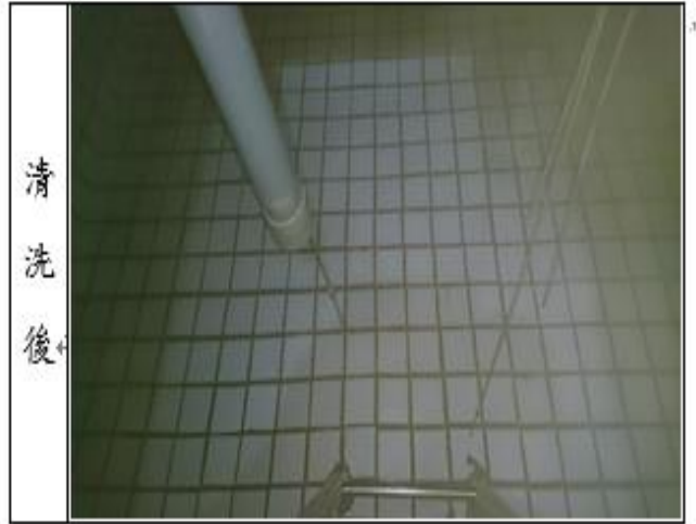
定期清洗水塔
